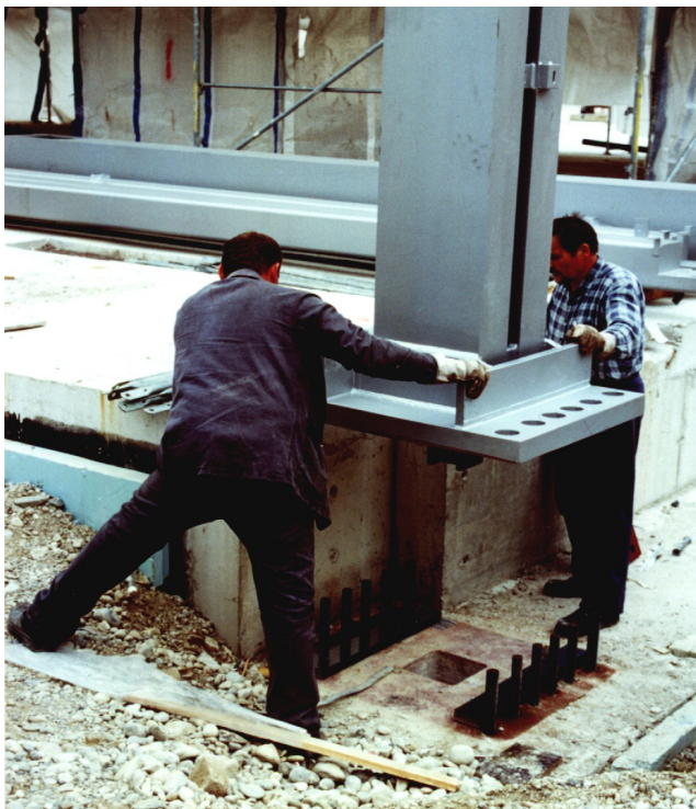
Bild 3. Montage der Stahlrahmen Fig. 3. Assembling of steel frames
