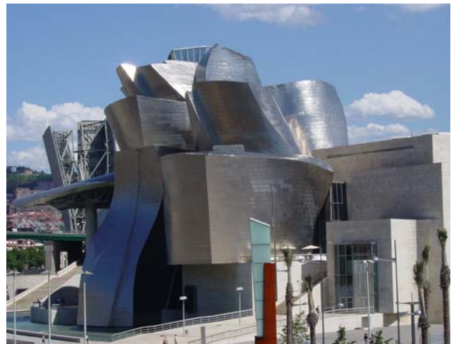
Bild 4: Guggenheimmuseum, Bilbao, Spanien, Titanblechverkleidung mit zweikomponentigem Silikon verklebt
