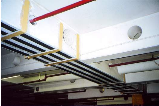
Bild 2: Aufgeklebte Kohlefaserlamellen an einem Stahlbetonunterzug [Laumer]
