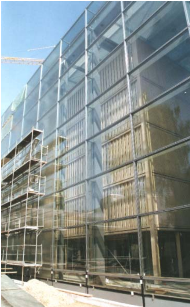
Bild 2 Seitenansicht der Glasfassade im Bau
